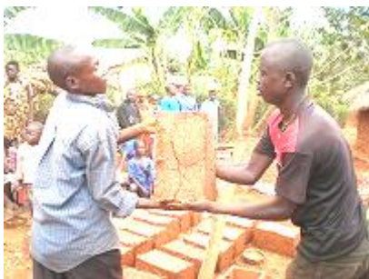
REACHの支援する償いの家造り現場
